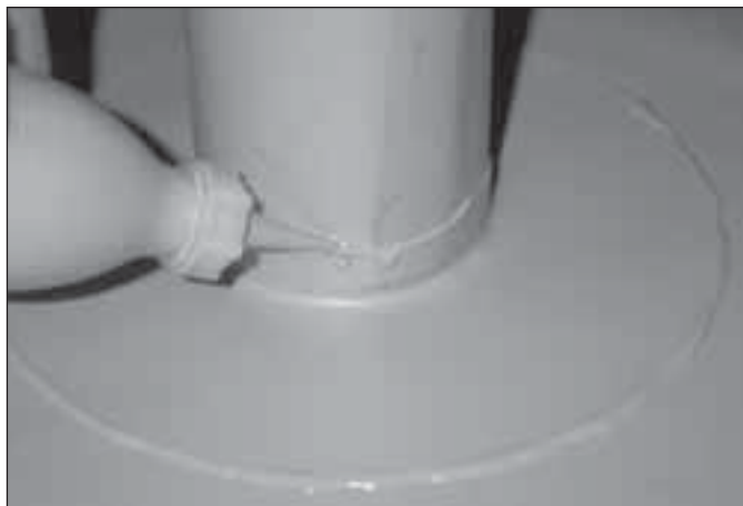
Applicazione di PVC liquido 81038
