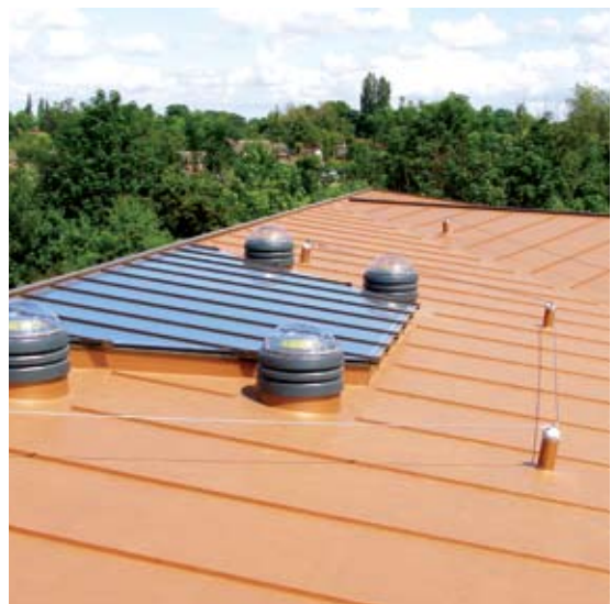
Rosemount NHS Krankenhaus (Grossbritannien)
